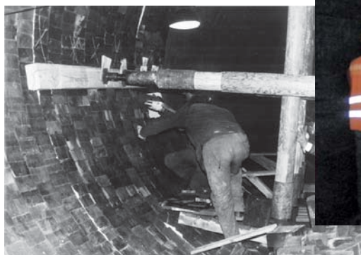
Obr. 3 Vyzdívání šamotovými cihlami
